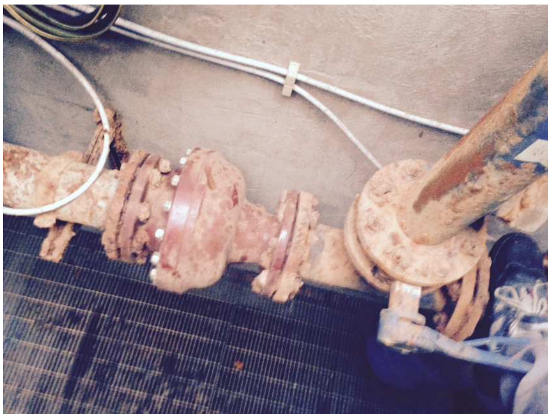
IMPIANTO DI POMPAGGIO VASCA VV.FF. IN MANUTENZIONE
