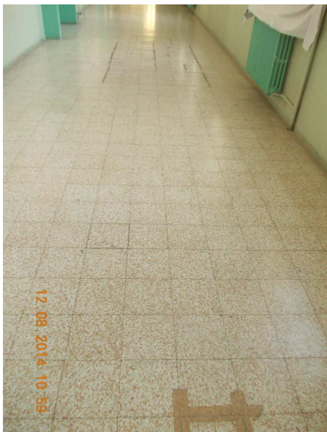
PAVIMENTAZIONI INTERNE AMMALORATE E DA SOSTITUIRE
