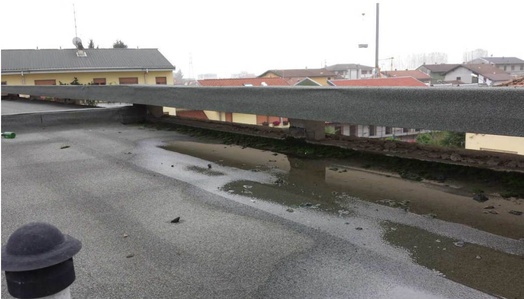
COPERTURA PIANA ZONA AMPILAMENTO - VELETTA DA MANTENERSI - MANUTENZIONE GUAINA PER NUOVO SPESSORE MURO+CAPPOTTO
