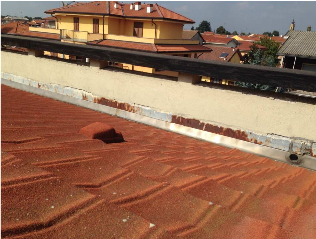
COPERTURA ALLA ORIGINARIA - DEMOLIZIONE DI VELETTE E CREAZIONE DI NUOVA FALDALERIA
